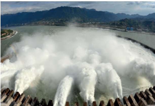
Fig. 3. Hidrocentrala „Cele trei defileuri” (China)
