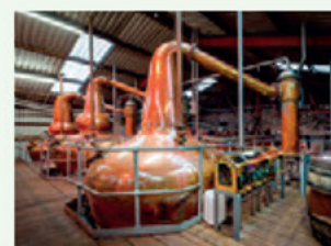
Instalație de distilare a băuturilor alcoolice
