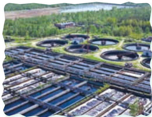
Bazine decantoare de apă
