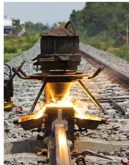
Figura 17 – Sudarea șinelor de cale ferată prin aluminotermie
