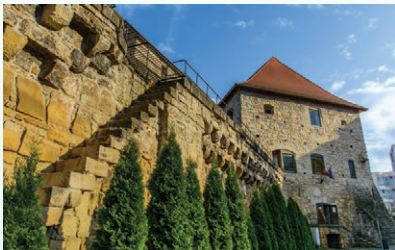
Turnul Croitorilor, Brașov.
